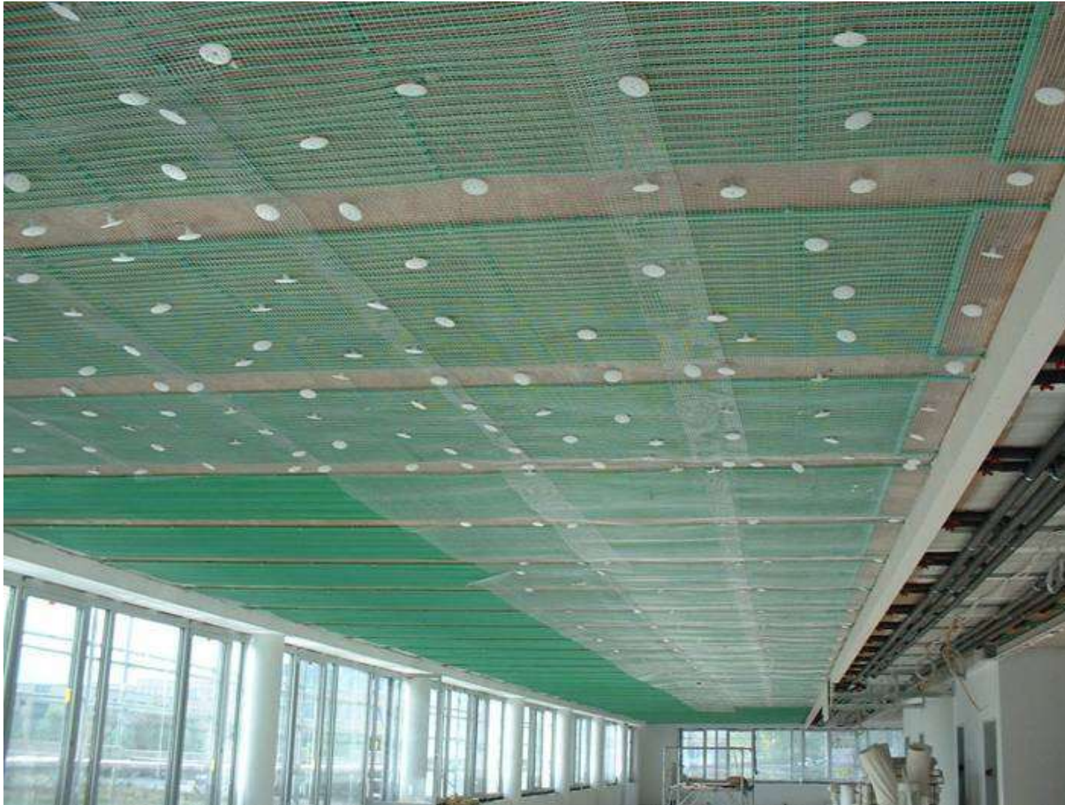
Vėsinamųjų lubų armavimas biurų pastate „Monzapark“, Darmštatas, Vokietija
