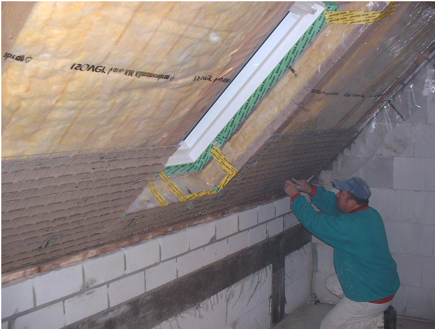
Palėpės aukšto rekonstrukcija
