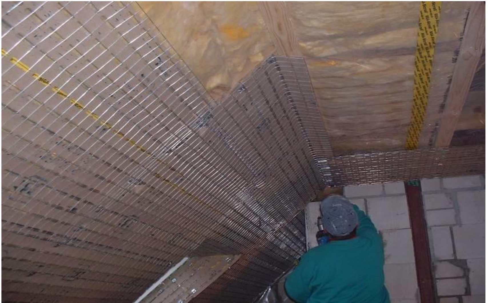
Palėpės aukšto rekonstrukcija
